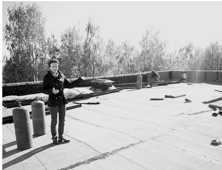
Работами на крыше здания Стрельнинского сельского Дома культуры его директор Вера Вячеславовна Денисова довольна.
